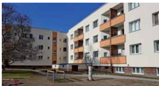
Wohnanlage in der Wünsdorfer Straße nach der Renovierung
